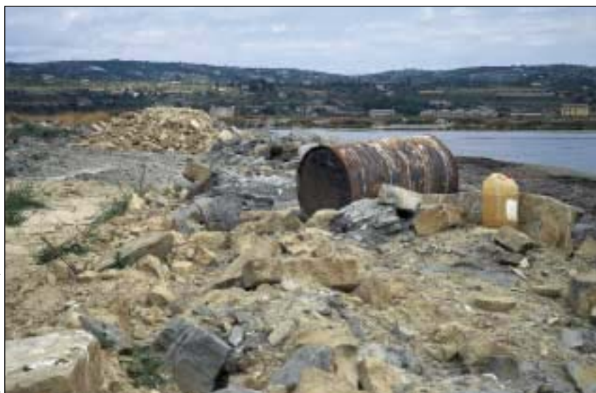
Slika 17. Neustrezno odlaganje odpadnega materiala pri gradnji dovozne poti v Sečoveljskih solinah.
