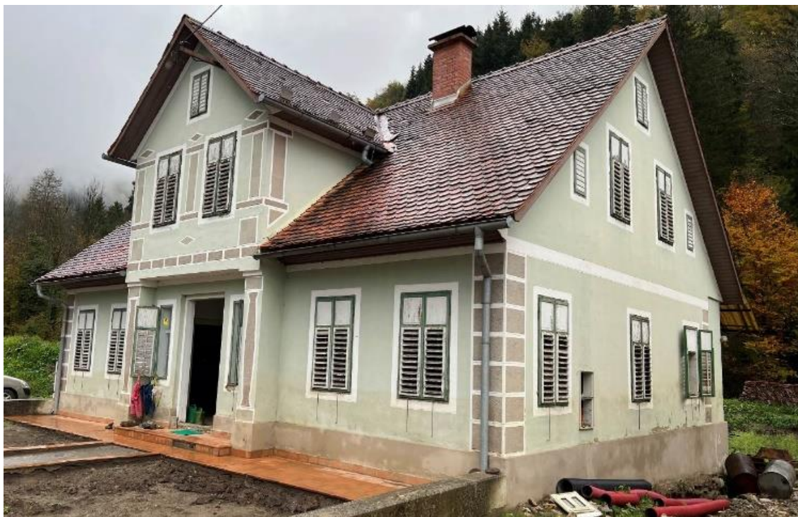
Fotografija 1: JV fasada z vidno linijo vode
