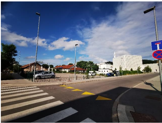
Foto 9: Pogled na Džamijsko ulico proti Muslimanskemu kulturnemu centru. V ospredju je območje PE1 z objekti, ki so predvideni za rušitev (Biljardna hiša) .
