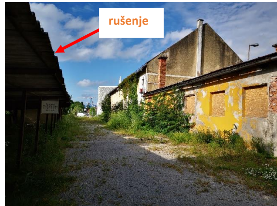
Foto 14: Sosednji objekti izven natečajnega območja na V strani. OPPN 173 Parmova načrtuje ohranitev stavb na desni in rušenje nadstrešnic na levi.
