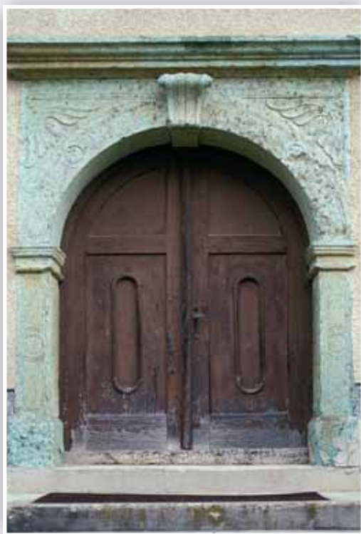
V Peračici pri Brezjah so pridobivali tuf kot okrasni kamen, ki je arhitekturna značilnost predvsem na Gorenjskem. Eden od opušenih kamnolomov te zelene kamnine je tudi na seznamu naše naravne dediščine. Foto Branka Hlad
