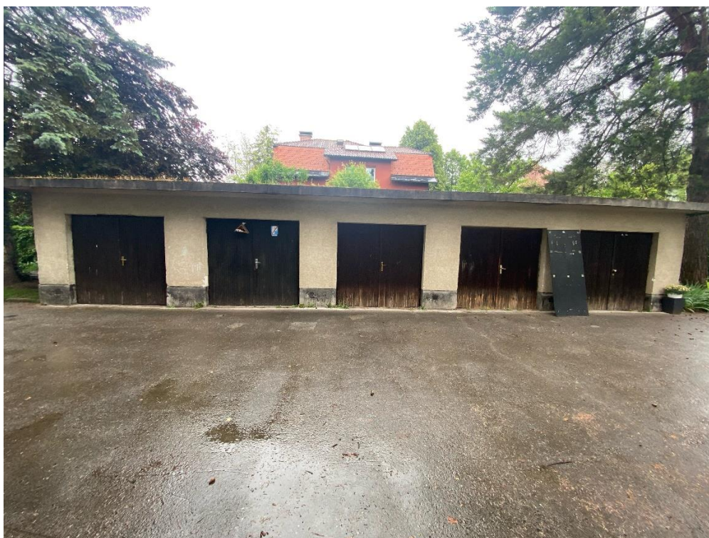
Slika 2: NIZ PETIH GARAŽ NA DVORIŠČU VEČSTANOVANJSKE STAVBE NA NASLOVU LEPI POT 14B, OD LEVE PROTI DESNI 2679-1501-1, 2679-1501-2, 2679-1501-3, 2679-1501-4 IN 2679-1501-5.
