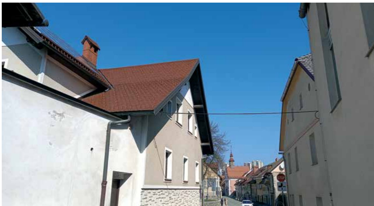
Slika 33: FN na strehi stavbe na levi, namestitve fotonapetostnih modulov na vzhodni strešini je izven izpostavljenega pogleda proti Spodnjemu trgu, Škofja Loka, EID 1-00738, foto M. Kavčič, 2023
