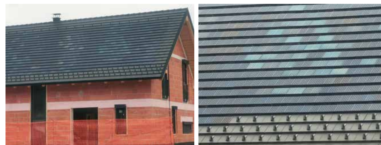
Sliki 30, 31: Integrirani fotonapetostni moduli, usklajeni z obliko in barvo strešnikov, Legen, foto M. Čas Zajc, 2023
