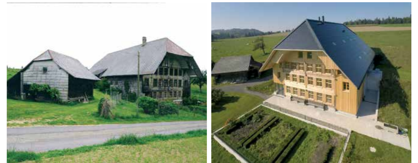
Slika 3, 4: Primer celovite prenove stavbne dediščine na podeželju z integriranimi moduli, ki nadomeščajo strešnike, Glaserhaus, Affoltern v Emmentalu, Švica ( https://www.hiberatlas.com/sl/glaserhaus-affoltern-im-emmental-switzerland--2-234.html , 11. 12. 2023)
