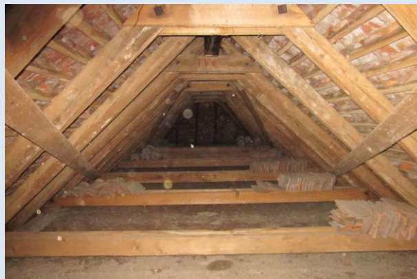
Slika 23: Tudi nateznih vezi in zavetrovanja ni dovoljeno odstraniti oziroma prežagati in ne dodatno obremenjevati.
