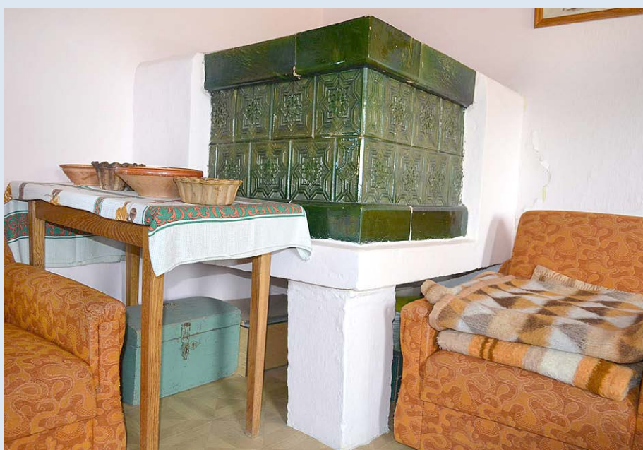
Slika 25: Nestrokovna umestitev lončene peči v prostor je povzročila občutno povečanje obremenitve lesenega stropa in zmanjšanje potresne varnosti stavbe.
