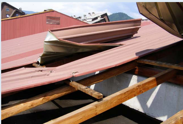
Slika 29: Neustrezno pritrjevanje letev z gladkimi žičniki.
