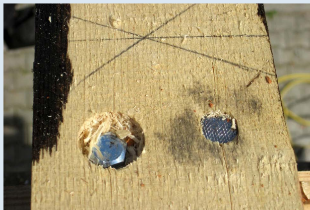
Slika 30: Za povezovanje se priporoča uporaba vijakov.
