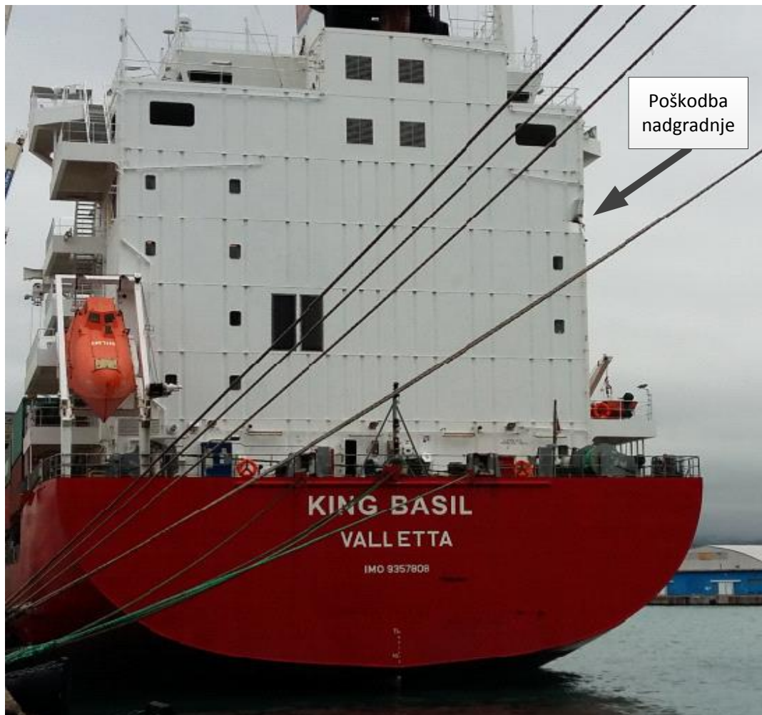
Slika 18: Poškodba nadgradnje na ladji KING BASIL
