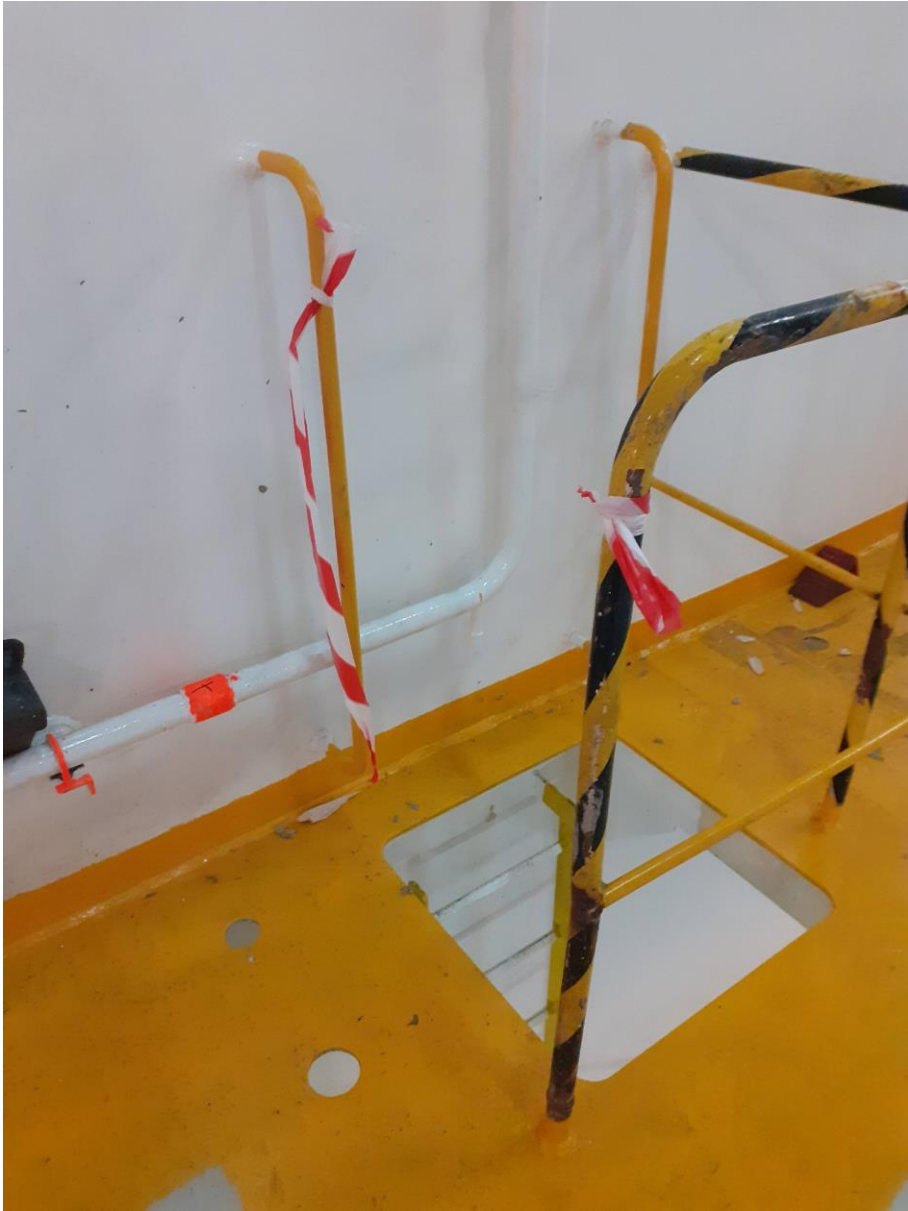
Slika 6 Nezdostno zaščiteni odprtine prehoda med palubami
