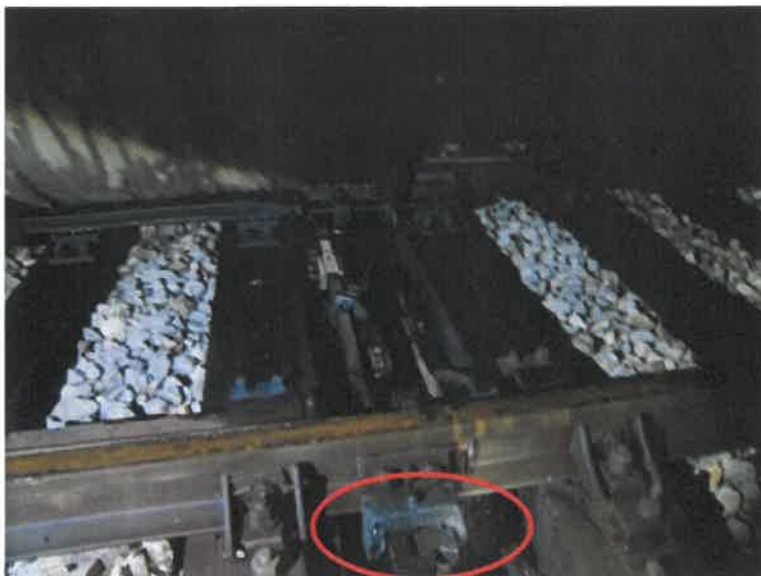
Slika št. 9: V rdečem rombu je prikazan nepopolno zapahnjjen lastovičji rep leve ostrice kretnice št. 6 postaje Kranj neposredno po nesreči
