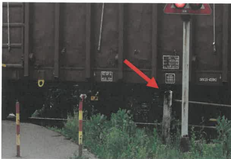
Slika št. 3: Rdeča puščica prikazuje dotrajano ograjo ob progi
