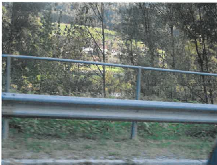
Slika št. 10: Primer odbojne ograje, ki bi jo bilo smiselno izgraditi med železniško progo in Cesto ob Barju
