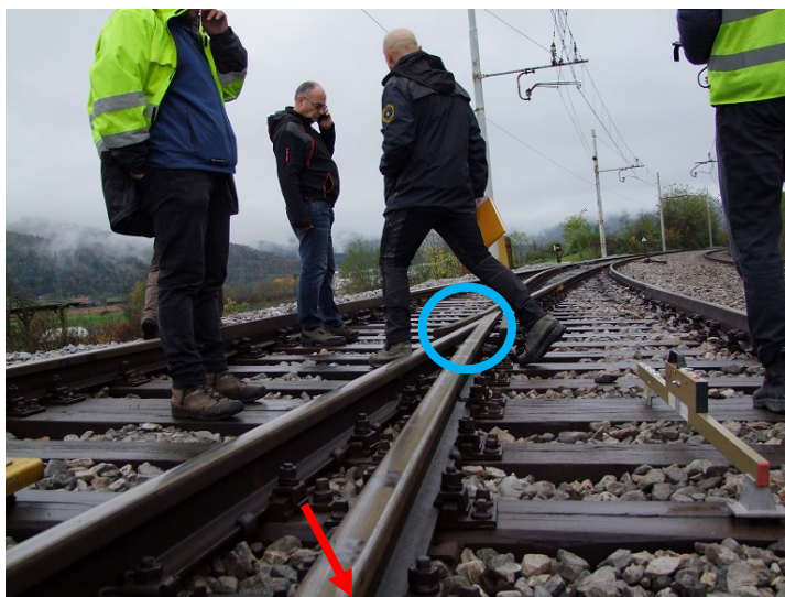
Slika št. 9: Rdeča puščica prikazuje pričetek sledi naplezanja levega kolesa, pred srcem kretnice št. 9, moder krog pa označuje, začetne sledi iztirjenja levega kolesa.
