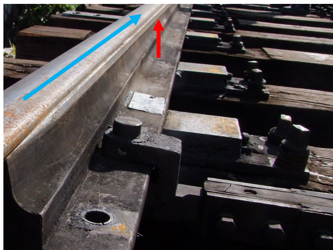
Slika št. 8: Rdeča puščica prikazuje pričetek sledi naplezanja vencev levih koles na glavo leve ostrice kretnice št. 1 med drugim in tretjim pragom, modra pa smer vožnje vlaka št. 41914.
