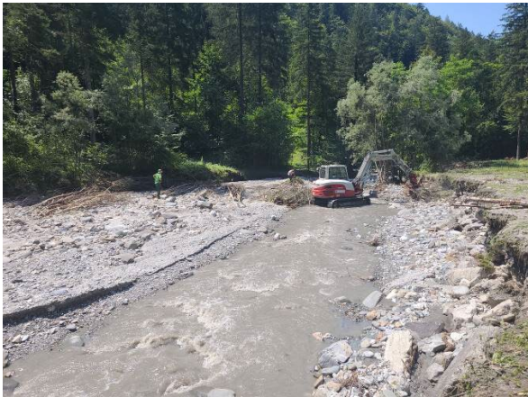
Slika 6: Sanacijska dela po ujmi na Cerknici in pogled na sotočje Cerknice in Idrijce, julij 2023
