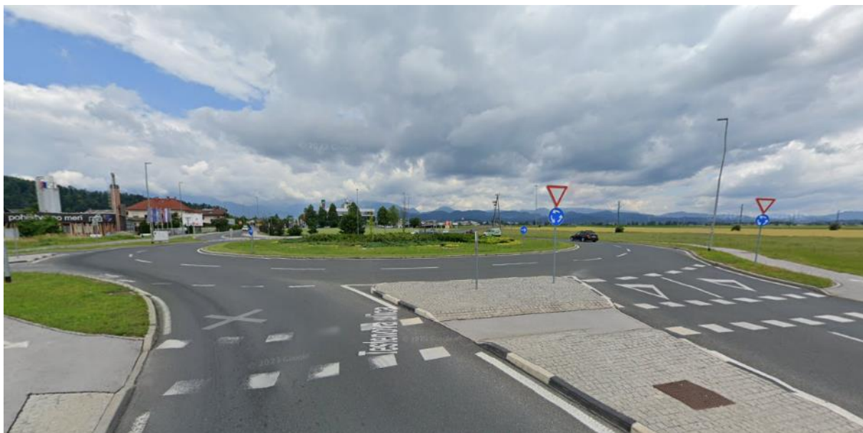
Slika 5. Krožno križišče izven naselja
