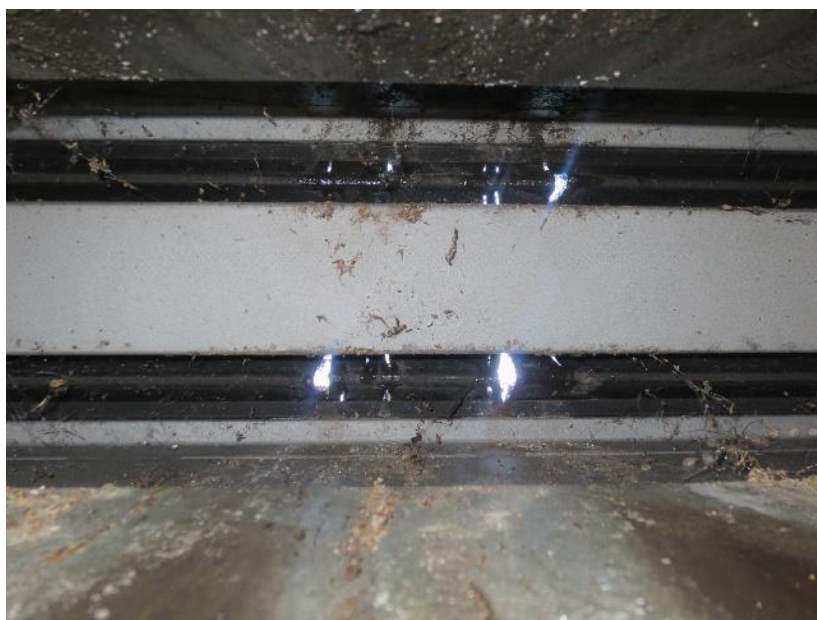
Slika 13.27: Preboj tesnilnih trakov v regah lamelne dilatacije – vodonetesnost
