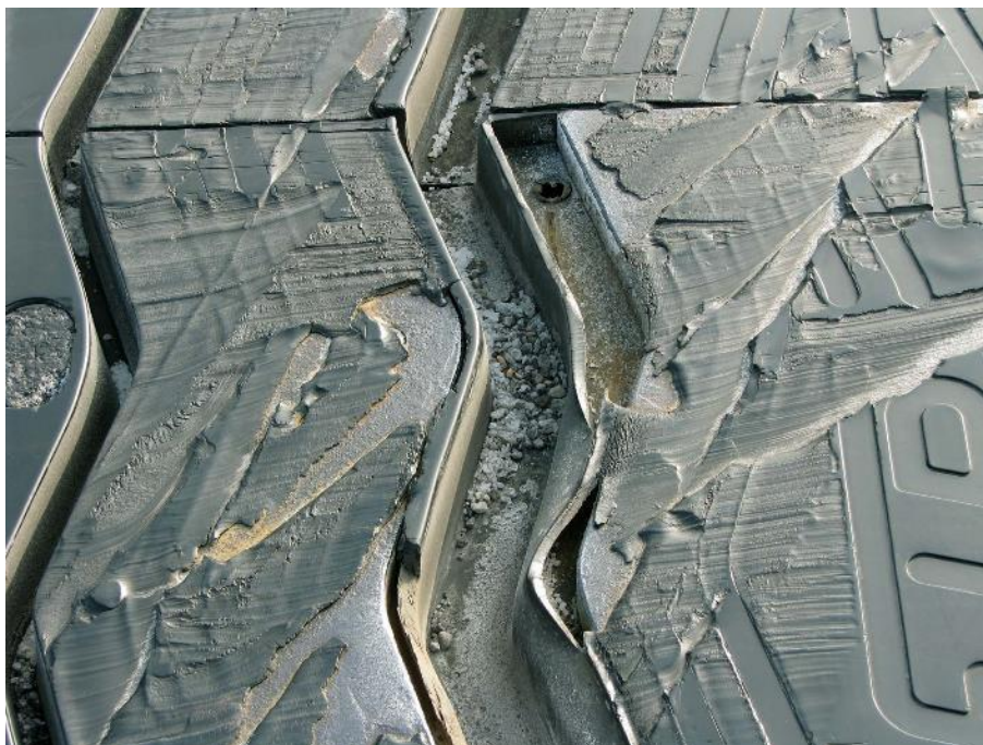
Slika 13.13: Končne posledice rezila snežnega pluga, spuščenega do ravnine dilatacije – pluzenje na »črno« - razgradnja blazinaste dilatacije med dilatiranjem
