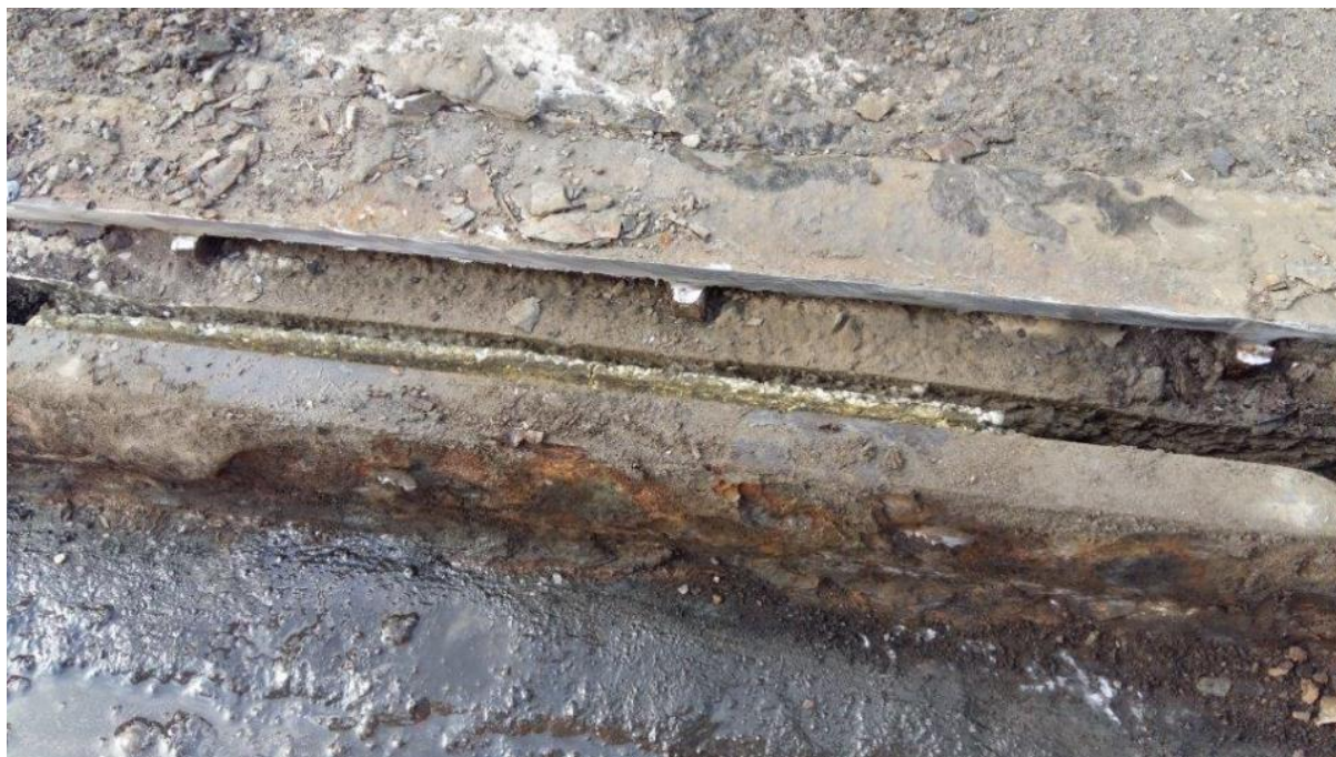
Slika 13.9: Primer nepodlitih mest betona pod robnim profilom (jeklena pasnica brez odprtin za odzračenje)
