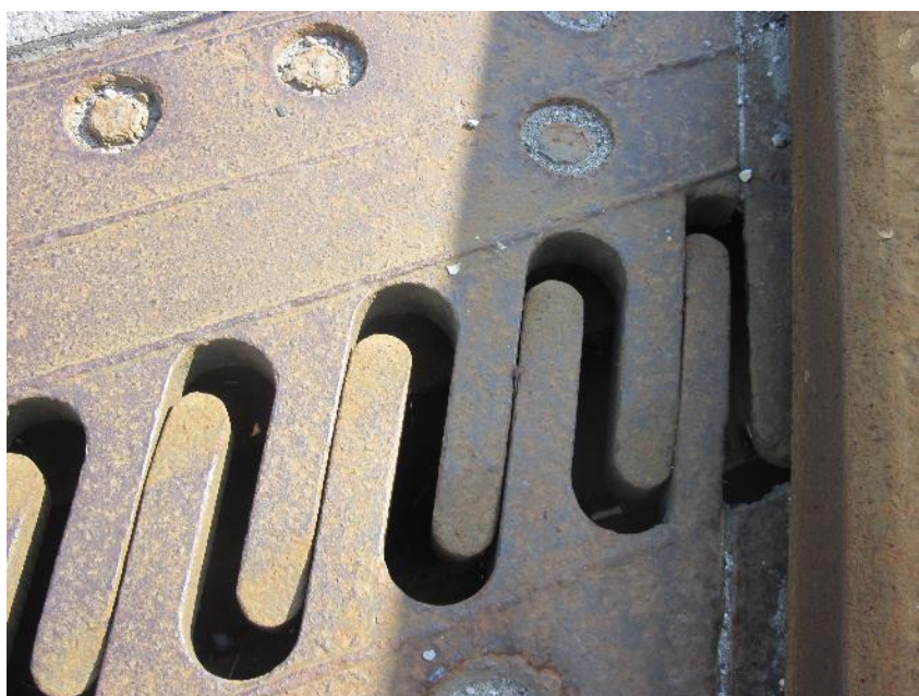
Slika 13.2: Primer neustrezne zasnove sheme spodnjih ležišč objekta - stikovanje glavnikov dilatacije zaradi polarnih vektorjev pomikov
