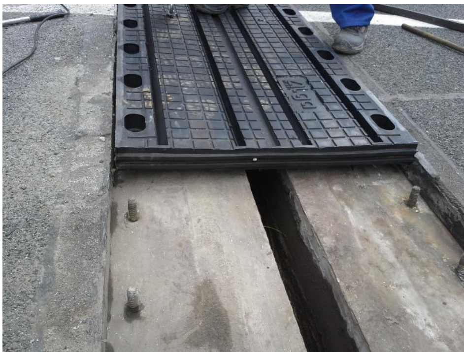
Slika 13.29: Stik blazinastega segmenta dilatacije – pogojna vodotesnost
