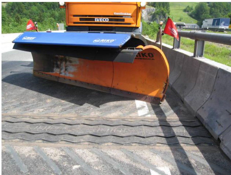
Slika 13.11: Rezilo snežnega pluga spuščeno do ravnine dilatacije – pluzenje na »črno«
