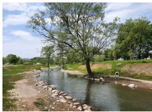
Razširitev struge Malega Grabna z ohranitvijo naravne strukture dna in vzpostavitev hidromorfoloških struktur (zatokov, prodišč, ribjih skrivališč) (projekt Gradaščica) (DRSV, 2023)
