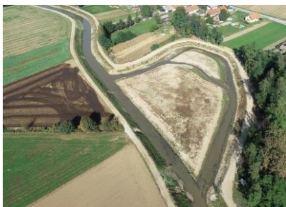
Obnova naravnega poteka struge Polskave z ohranitvijo regulirane struge (projekt Dravinja s Polskavo) (DRSV, 2024)
