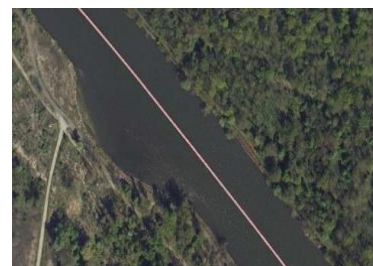
Odstranitev obrežnega zavarovanja izvedba odmaknjene vkopane pasivne obrežne zavarovanja na Muri v Segovcih za naravno rečno dinamiko (Pomgrad VGP d.d., 2012)
