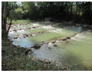
Nadomestitev neprehodne pregrade z zaporedjem nižjih prehodnih pragov s prelivnim poljem in prepustnim podslapljem na Vipavi (DRSV, 2021)
