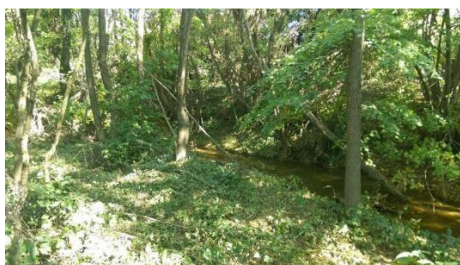
Selectivna odstranitev (poškodovane, odmrle) obrežne vegetacije z ohranitvijo zrele obrežne vegetacije na Kobiljskem potoku od državne meje z Madžarsko do vtoka Ratkovskega potoka (Pomgrad VGP d.d., 2017)
