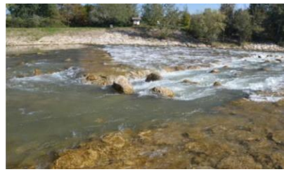
Sanacija Šeške drče na Savinji z vzpostavitvijo prehodne hrupave drče in zavite ribje steze na telesu drče (NIVO Eko d.o.o., 2018)
