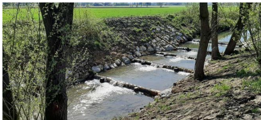
Zamenjava betonskih pragov na Kobili v Draškovcu z zaporedjem nižjih lesenih pragov s prelivnim poljem in prepustnim podslapljem (porečje Krke) (VGP Novo mesto d.d., 2020)
