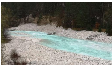
Izvedba točkovnih obrežnih zavarovanj -odbijačev, brez vmesnih utrditev na Soči pod Hovsnerjem (Hidrotehnika d.d., 2019)
