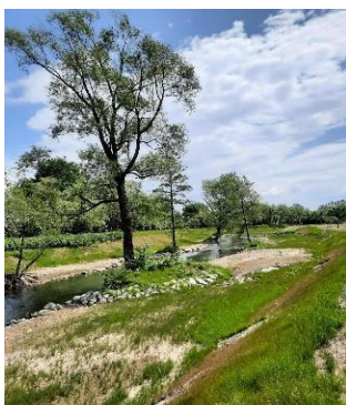
Razširitev struge Malega Grabna z ohranitvijo naravne strukture dna in vzpostavitev hidromorfoloških struktur (zatokov, prodišč, ribjih skrivališč) (projekt Gradaščica) (DRSV, 2023)
