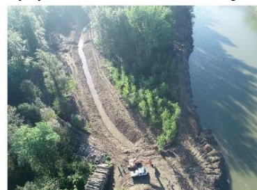
Obnova rokava Dokležovje I na Muri (izkop in obnova vtoka) za vzpostavitev naravne rečne dinamike in izboljšanje stanja habitatov (NaturaMura) (DRSV, 2022)
