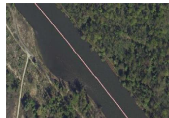
Odstranitev obrežnega zavarovanja izvedba odmaknjene vkopane pasivnega obrežnega zavarovanja na Muri v Segovcih za naravno rečno dinamiko (Pomgrad VGP d.d., 2012)
