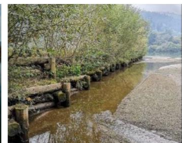
Obrežno zavarovanje z leseno kašto na Erhatovem potoku (VGP Drava, 2015)
