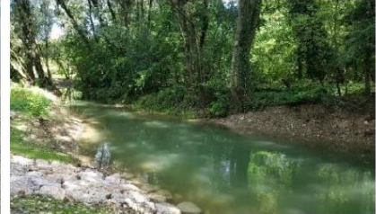
Izboljšanje hidromorfoloških značilnosti in pretočnosti s poglobitvijo rokava Brje in izgradnjo usedalnikov plavin na rokavu Brje na Vipavi (VIPava) (DRSV, 2021)
