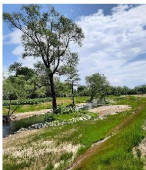
Razširitev struge Malega Grabna z ohranitvijo naravne strukture dna in vzpostavitvijo hidromorfoloških struktur (zatokov, prodišč, ribjih skrivališč) (projekt Gradaščica) (DRSV, 2023)
