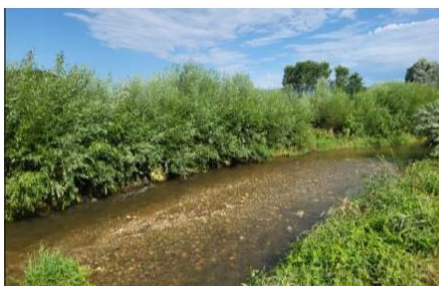
Obrežno zavarovanje na Dravinji z vrbovimi popleti in kamnito peto brežine (LIFE-IP Natura.si) (DRSV, 2023)
