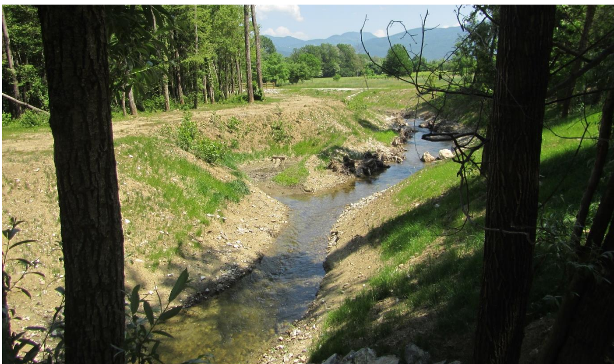
Slika 11: Vzpostavitev stranskega rokava Vipave po izgradnji (DRSV, 2022)
