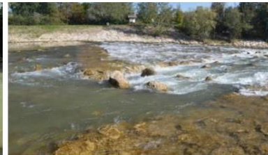
Sanacija Šeške drče na Savinji z vzpostavitvijo prehodne hrapave drče in zavite ribje steze na telesu drče (NIVO Eko d.o.o., 2018)
