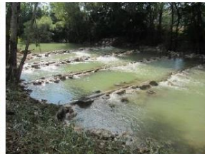
Nadomestitev neprehodne pregrade z zaporedjem nižjih prehodnih pragov s prelivnim poljem in prepustnim podslapjem na Vipavi (DRSV, 2021)
