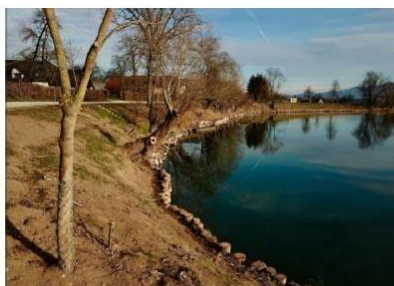
Obrežno zavarovanje s piloti na Krki (VGP Novo mesto, 2018)
