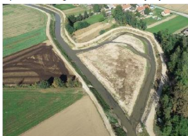
Obnova naravnega poteka struge Polskave z ohranitvijo regulirane struge (projekt Dravinja s Polskavo) (DRSV, 2024)
