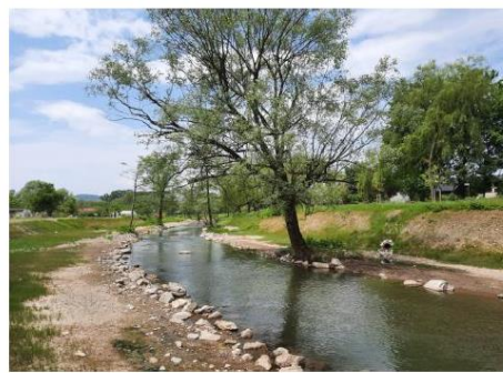
Razširitev struge Malega Grabna z ohranitvijo naravne strukture dna in vzpostavitvijo hidromorfoloških struktur (zatokov, prodišč, ribjih skrivališč) (projekt Gradaščica) (DRSV, 2023)
