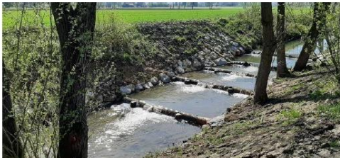
Zamenjava betonskih pragov na Kobilu v Draškovcu z zaporedjem nižjih lesenih pragov s prelivnim poljem in prepustnim podslapjem (porečje Krke) (VGP Novo mesto d.d., 2020)
