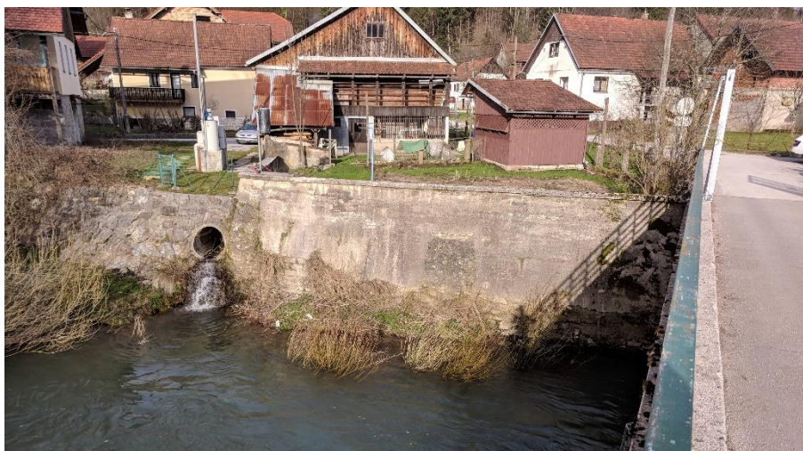
Slika 4. Betonski zid tik gorvodno od zidu, iztok meteornega kanala.
