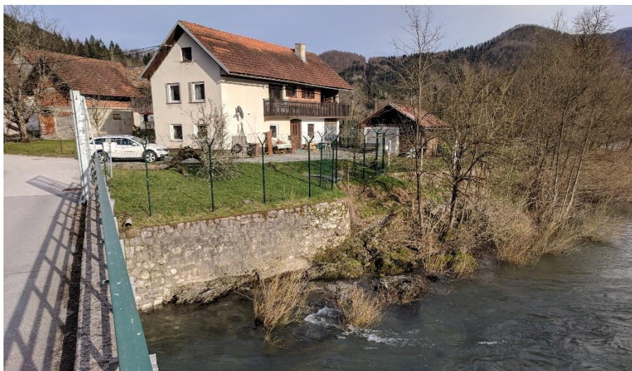
Slika 5. Ureditev dolvodno od mostu.
