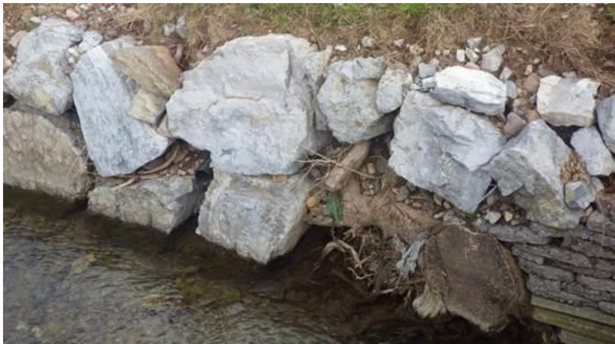
Slika 14: Prikaz za ribe ustreznega načina utrjevanja brežine - nezapolnjene luknje in špranje, ki ribam služijo kot skrivališča. Razmik med kamni oz. skalami ni zalit z betonom. Pri tem opozarjamo, da sliko prikazujemo samo zaradi prikaza ustreznega razmika med posameznimi skalami, neustrezna pa je izrazita poravnost površine utrditve, ki bi morala biti bolj hrapava oz. nepravilna.
