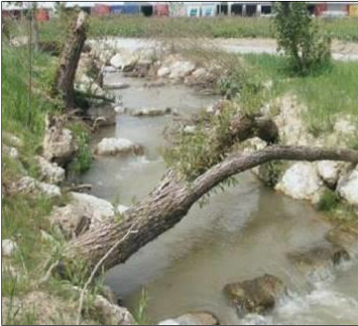
Slika 1: Primer izvedbe izrazito nepravilnih utrjenih brežin s skalami samice in kamni (privzeto iz Grundlagen für einen österreichischen Leitfaden zum Bau von Fischaufstiegshilfen (FAHs). Bundesministerium für Land- und Forstwirtschaft, Umwelt und Wasserwirtschaft, Wien, 2011).
