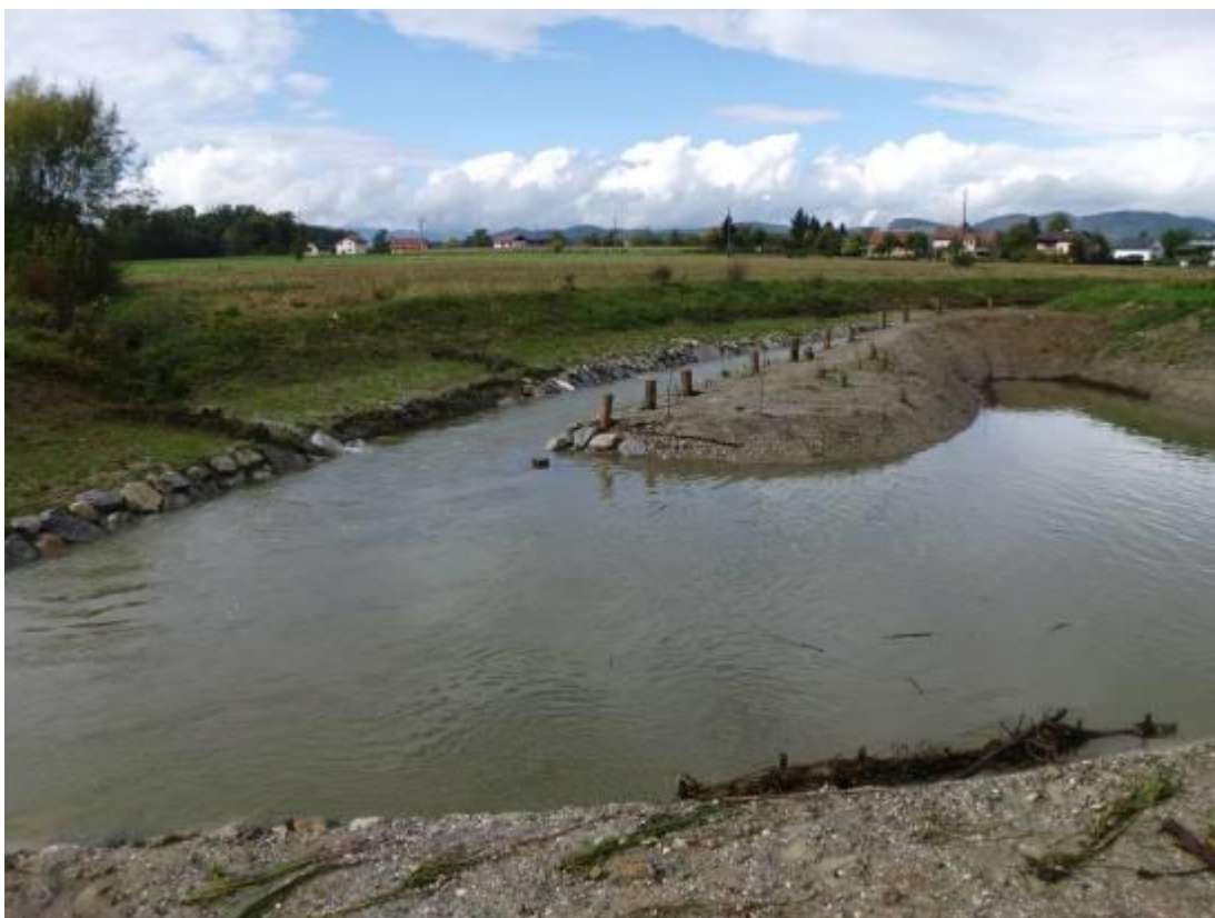
Slika 17: Primer izvedbe nadomestnega habitata - zatón (Sušnica; dolvodni pogled).
