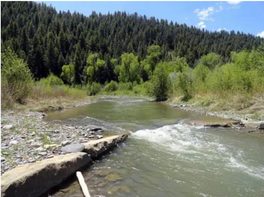
Slika 9: Prehoden prag s podslapnim tolmunom.
