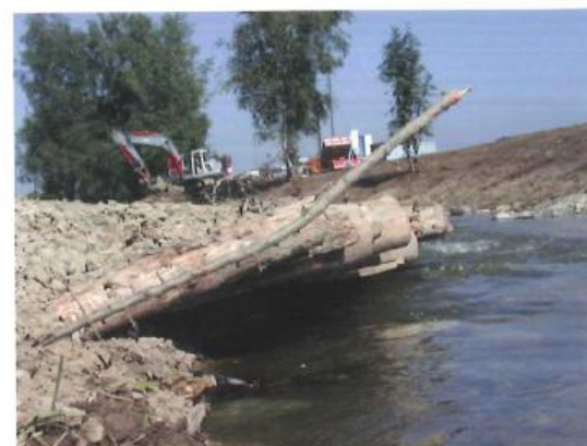
Slika 12: Možnosti za izvedbo sonaravno oblikovanih skrivališč za ribe ob brežinah [str. 1 od 2] (privzeto iz Entwicklung naturnaher Bäche und Flüsse, Gebler 2005).
