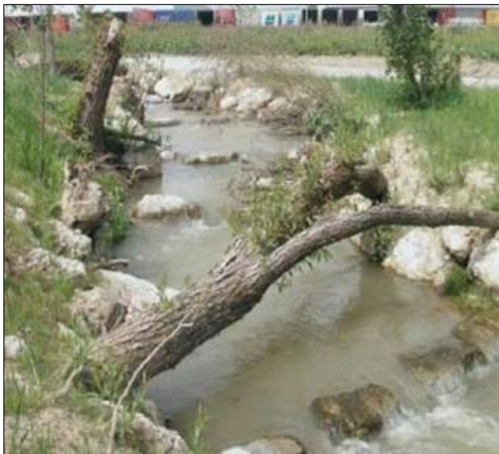
Slika 1: Primer izvedbe izrazito neporavnanih utrjenih brežin s skalami samcami in kamni (privzeto iz Grundlagen für einen österreichischen Leitfaden zum Bau von Fischaufstiegshilfen (FAHs). Bundesministerium für Land- und Forstwirtschaft, Umwelt und Wasserwirtschaft, Wien, 2011).
