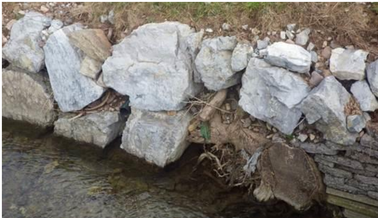
Slika 14: Prikaz za ribe ustreznega načina utrjevanja brežine - nezapolnjene luknje in špranje, ki ribam služijo kot skrivališča. Razmik med kamni oz. skalami ni zalit z betonom. Pri tem opozarjamo, da sliko prikazujemo samo zaradi prikaza ustreznega razmika med posameznimi skalami, neustrezna pa je izrazita poravnost površine utrditve, ki bi morala biti bolj hrapava oz. nepravilna.
