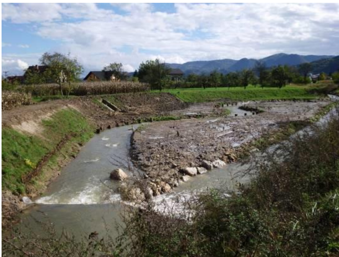
Slika 15: Primer izvedbe sonaravno oblikovane obvodne struge (levo), ki predstavlja nadomestni habitat za ribe (Sušnica; dolvodni pogled).
