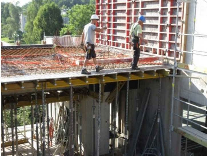
Slika 9: Nevarno izvajanje dela na višini
