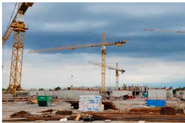
Gradbišče novega zapora v Dobrunjah: izgradnja zaprtega in upravnega dela zavoda
