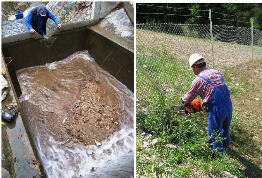
Slika 21: Čiščenje usedline merilnega mesta po deževju (levo) in čiščenje podrasti ob varovalni ograji Boršt (desno)
