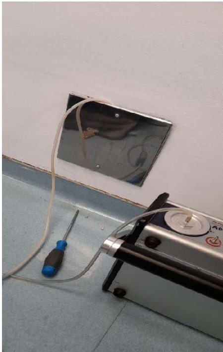
Slika 75. Ventil za vodo v steni
