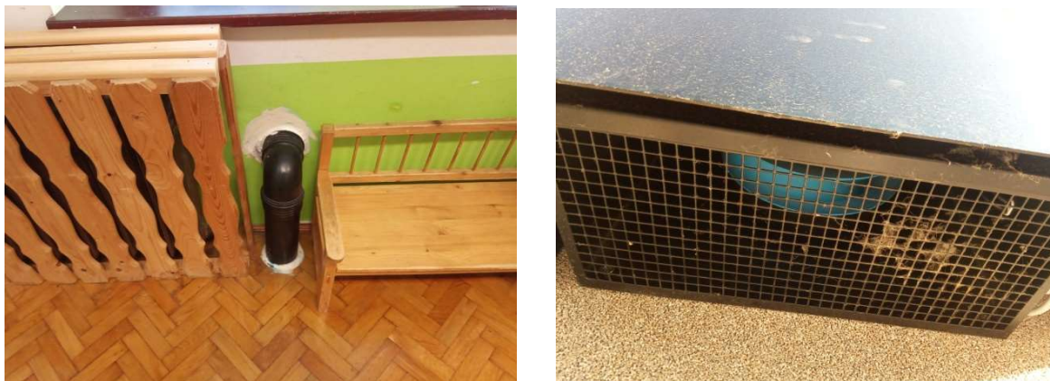
Slika 15. Izvedba sanacije, cev v prostoru in izpuh na prostem
