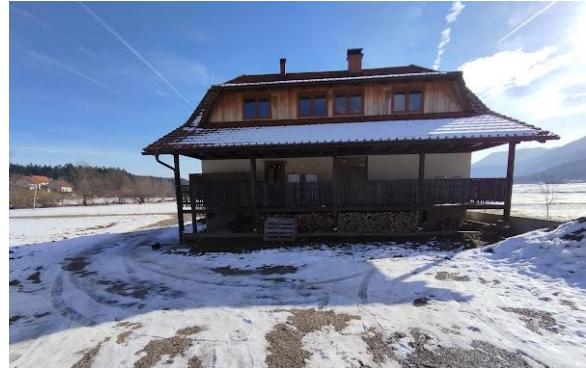
Fotografija 2: Pogled iz smeri Z .. stavba 455 (hiša)
