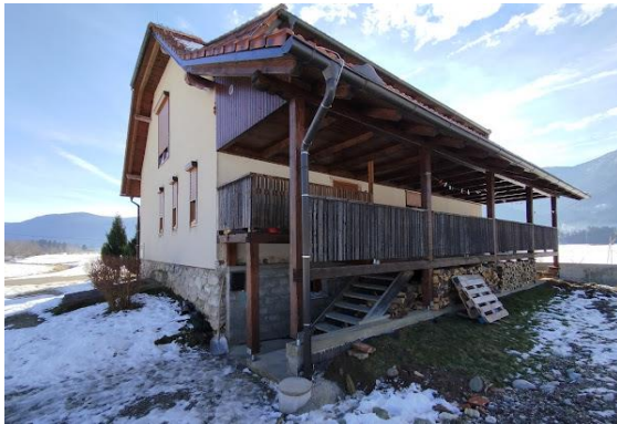
Fotografija 3: Pogled iz smeri SZ .. stavba 455 (hiša)
