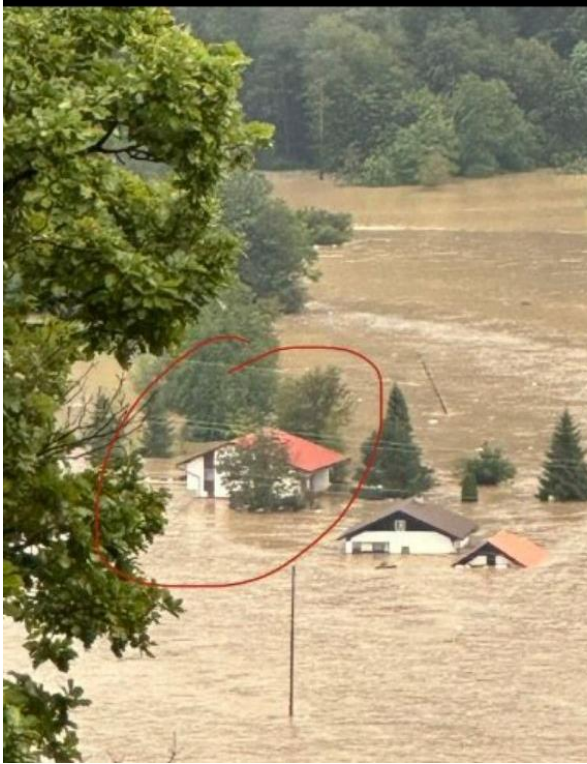
Fotografija 1: Pogled iz S strani na sklop hiš Loke pri Mozirju 43 (označeno) in 47 med poplavami – 4.8.2023
