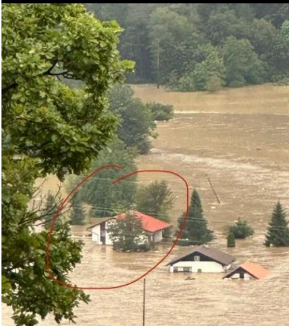
Fotografija 1: Pogled iz S strani na sklop hiš Loke pri Mozirju 43, 43a (označeno) in 47 med poplavami – 4.8.2023
