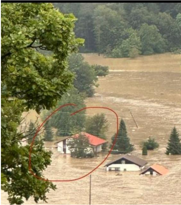
Fotografija 1: Pogled iz S strani na sklop hiš Loke pri Mozirju 43, 43a (označeno) in 47 med poplavami – 4.8.2023
