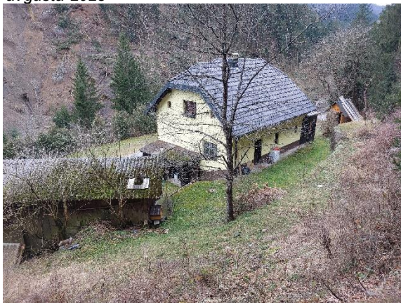
Fotografija 3: Pogled na stavbo št. 62 z zaledne brežine
