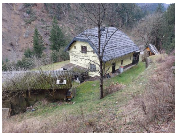
Fotografija 4: Pogled na zaledno brežino (5.1.2024).
