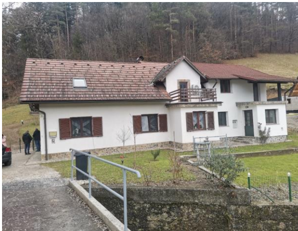
Fotografija 2: Pogled na J fasado objekta
