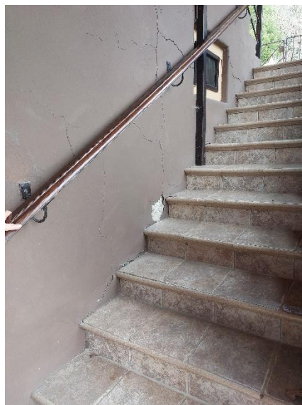
Fotografija 6: Popokane zunanje stene na stopnišču (13.3.2024)
