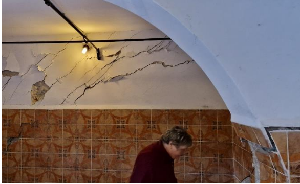
Fotografija 3: Vodoravni zamik objekta zaradi bočnih pritiskov
