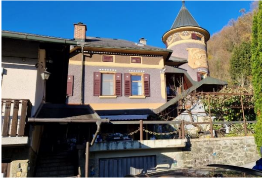
Fotografija 1: Pogled na objekt z vzhodne strani
