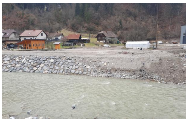
Slika 27: Odstranjen objekt in sanirana desna brežina (vir: VGB Maribor)
