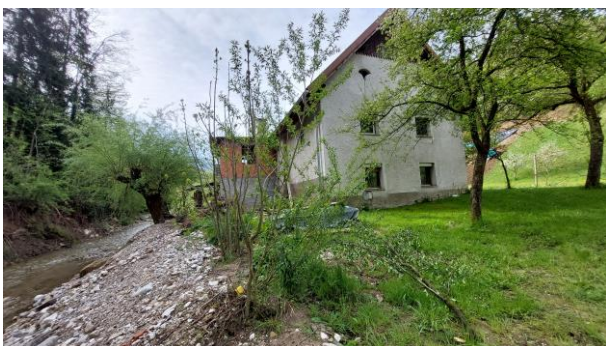
Fotografija 3: Pogled na Javornik 14, ki se nahaja tik ob strugi vodotoka (19.4.2024).
