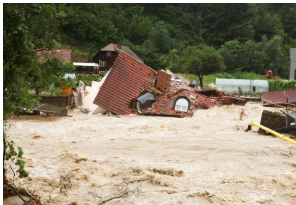
Slika 25: Posnetek porušenega objekta v času poplave (vir: www.24ur.com )
