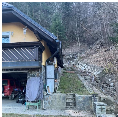
Slika 13: Objekt in hudournik ob objektu (vir: VGB Maribor d.o.o., februar 2024)
