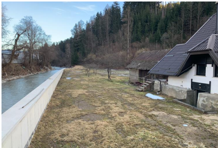
Slika 31: Prikaz visokovodnega zidu in objekta Nicina 11
