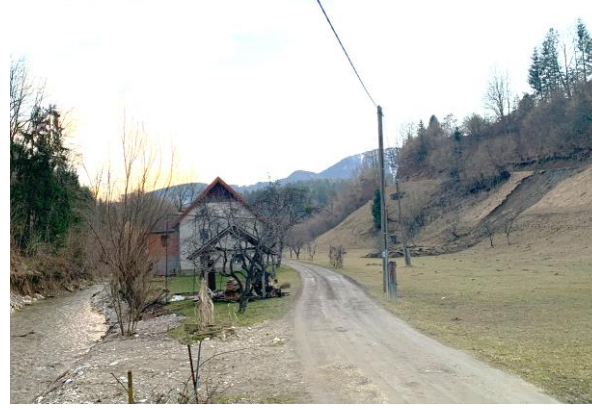
Slika 38: Objekt Javornik 14, desno na sliki viden plaz (vir: VGB Maribor)
