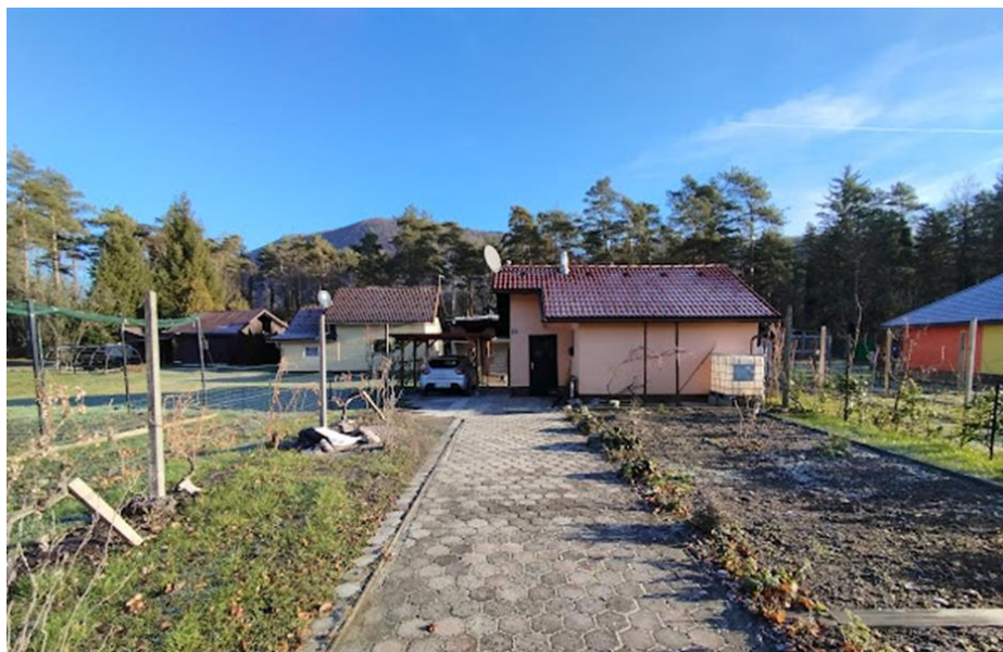
Slika 2: Pogled iz smeri JZ na objekt
