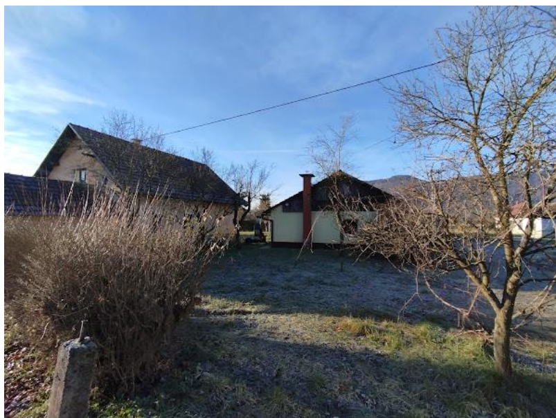
Slika 2 Pogled iz smeri SV stavba 807
