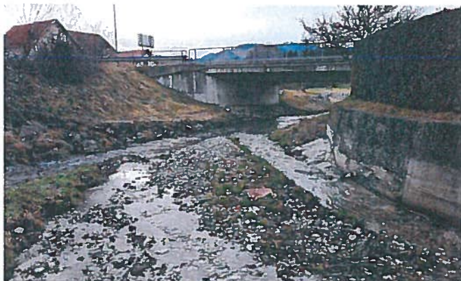
Slika 25: Most dolvodno od objekta, viden je desnobrežni oporni zid
