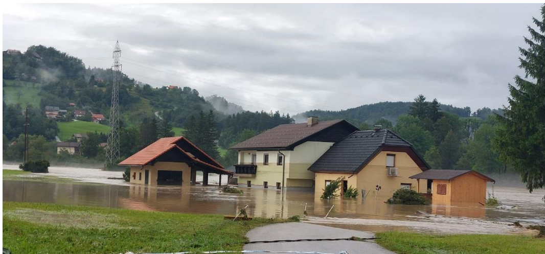
Slika 15: območje objektov Loke pri Mozirju 43, 43A, 47 in 47A (vir: DRSV)
