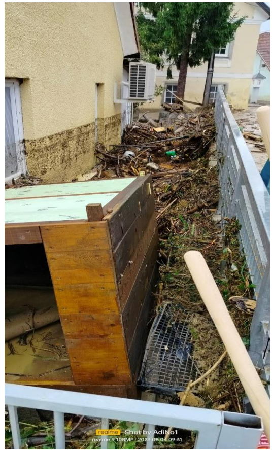
Fotografija 4: Stanje med poplavami dne 4.8.2023.
