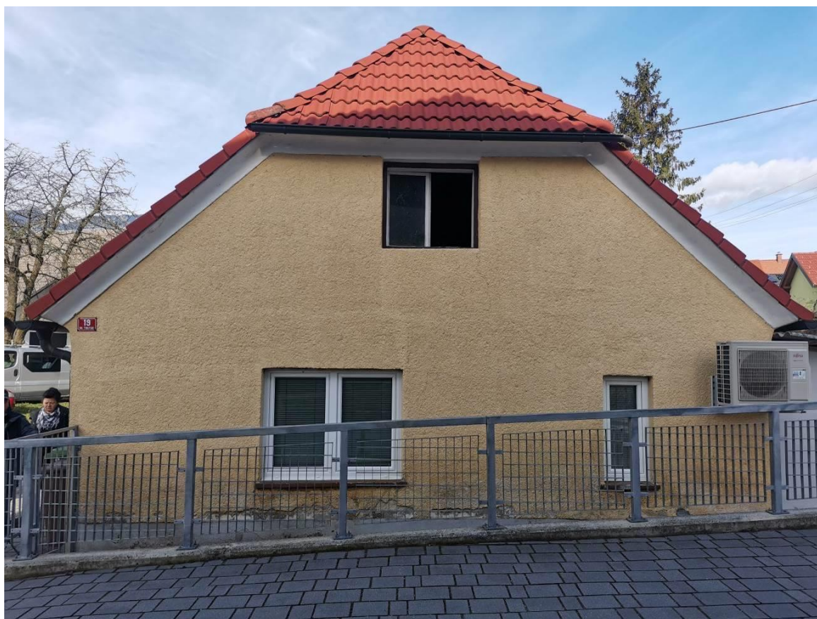
Fotografija 2: Izvorna kota terena je nižja od sosednjega terena oz. ceste, most čez reko predstavlja dodatno prepreko pretoku vodotoka
