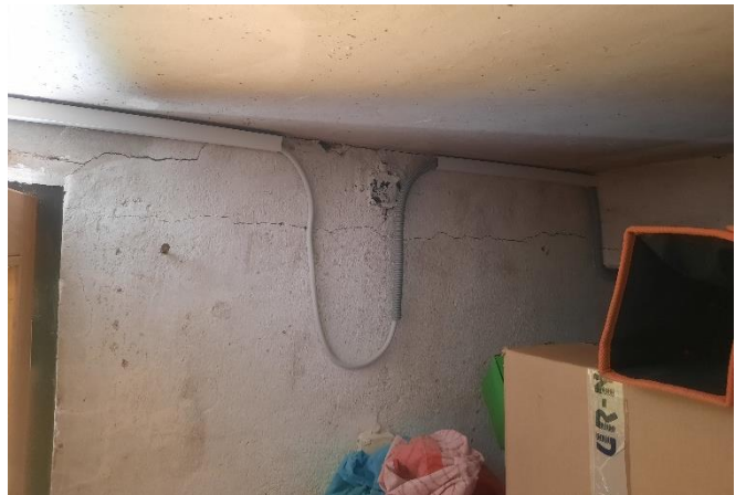
Fotografija 6: Ista razpoka kot na prejšnji sliki, ampak iz notranje strani.
