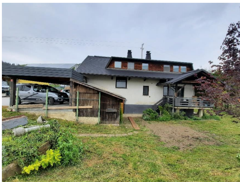
Fotografija 2: Izvorna kota terena je nižja od sosednjega nasutega terena oz. ceste, klet je še dodatno vkopana; poplavna voda je segala skoraj do zgornjega okna
