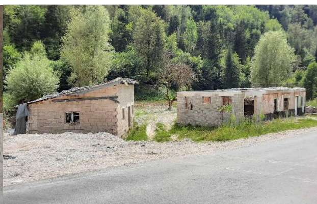
Fotografija 3: Objekt po poplavah – pogled z SV strani
