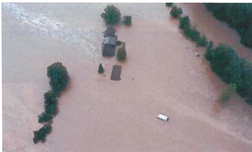
Slika 11: Prikaz lokacije obravnavanega objekta v času poplav avgusta 2023 (vir: internet).
