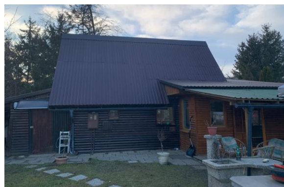
Slika 36: Objekt Pod gonjami 160 (vir: VGB Maribor)
