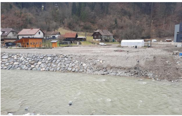
Slika 28: Odstranjen objekt in sanirana desna brežina (vir: VGB Maribor)
