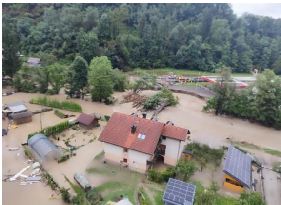
Slika 25: Posnetek objekta in zamašenega mostu s plavjem (pred poružitvijo), vir: Gorska reševalna zveza Slovenije
