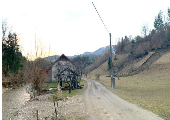
Slika 39: Objekt Javornik 14, desno na sliki viden plaz (vir: VGB Maribor)
