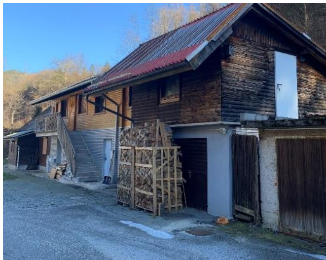
Slika 3: Objekt Pristava 3, Črna na Koroškem v februarju 2024 (vir: VGB Maribor d.o.o.)
