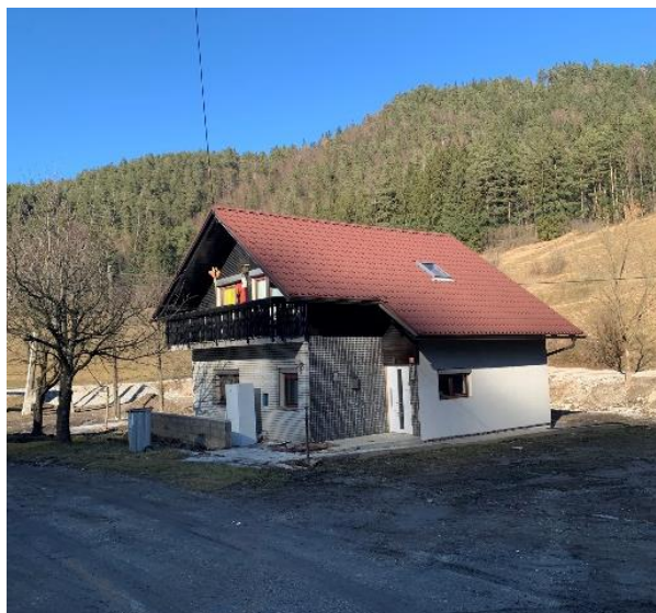
Slika 10: Objekt Polena 19 v februarju 2024 (vir: VGB Maribor d.o.o.)
