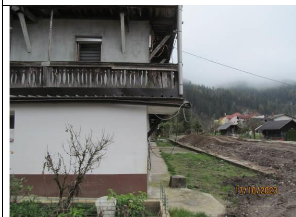
Povešen balkon nad pritličjem na severni strani
