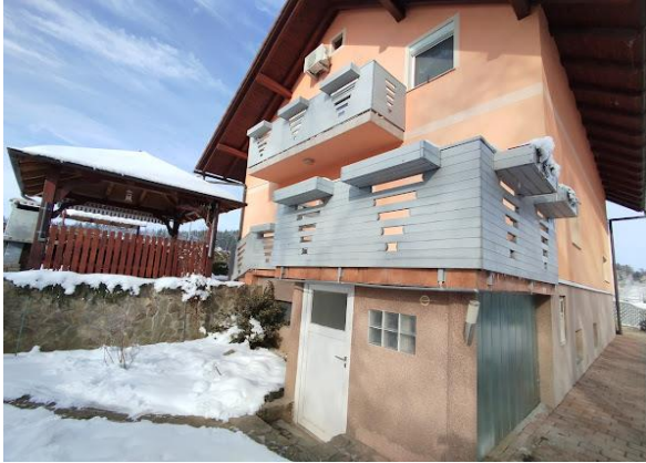
Fotografija 3: Pogled iz smeri J .. vrtni nadstrešek in stavba 920
