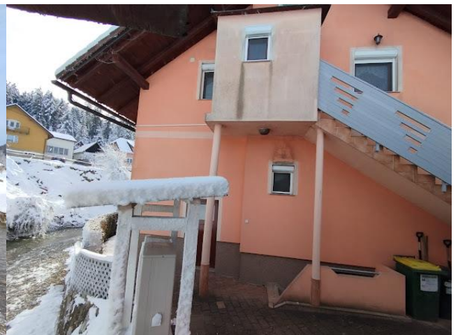
Fotografija 6: Pogled iz smeri S .. stavba 920 (hiša)
