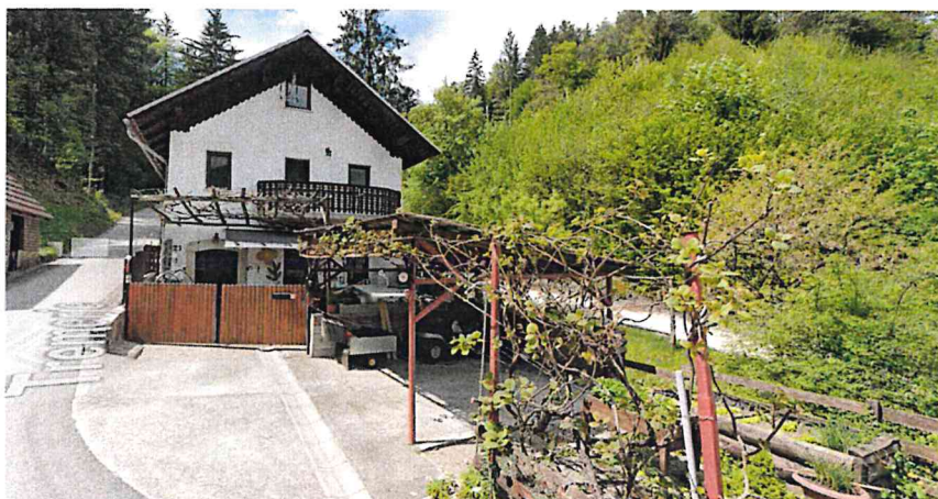
Slika 16: Objekt Tremerje 21 (Vir: Google street View)
