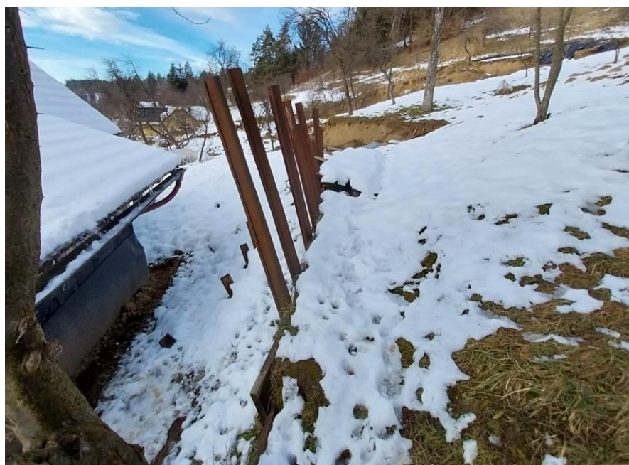
Slika 6 Arnače 14, v zaledju stanovanjskega objekta izveden začasni oporni zid iz jeklenih traverz in lesenih plohov
