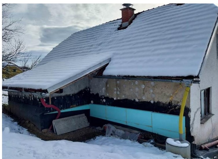
Slika 4 Arnače 14, SV fasada stanovanjskega objekta
