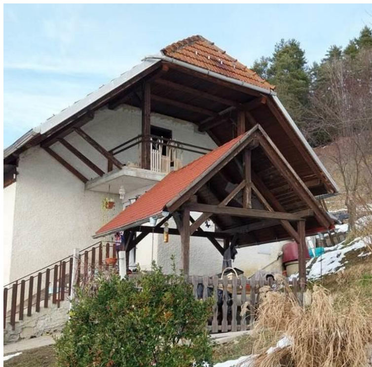
Slika 3v Arnače 14, JV fasada stanovanjskega objekta
