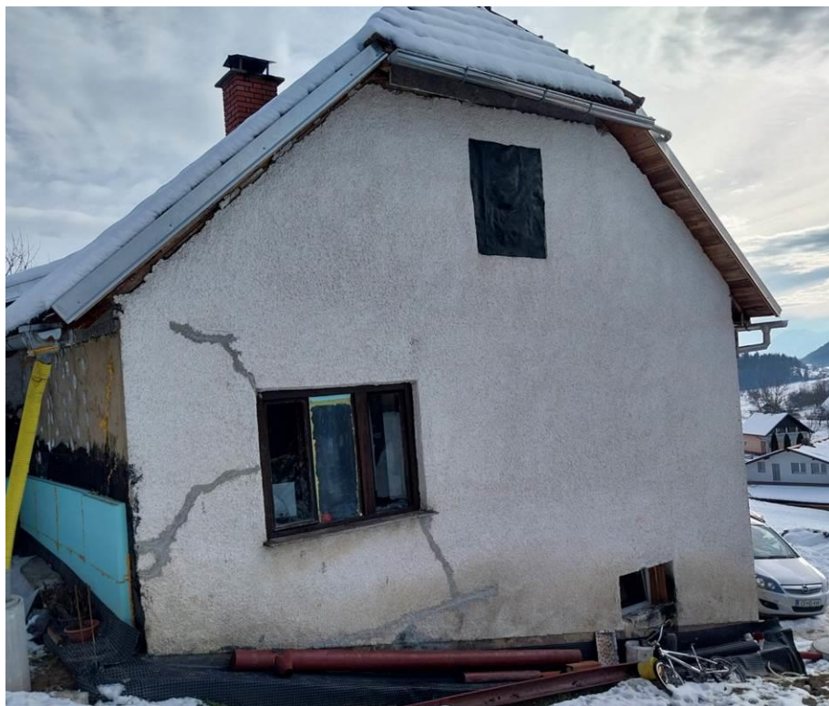
Slika 5 Arnače 14, SZ fasada stanovanjskega objekta
