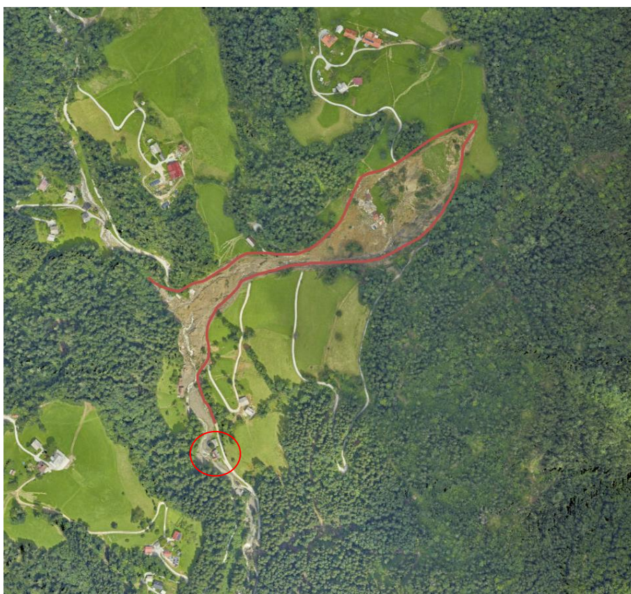
Slika 1: Pogled (DOF) na lokacijo splazitve – po Ujmi 2023. Z rdečo barvo je označen obravnavani objekt Konjski vrh 33
