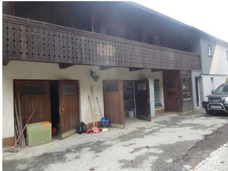
Slika 2: severna stran objekta
