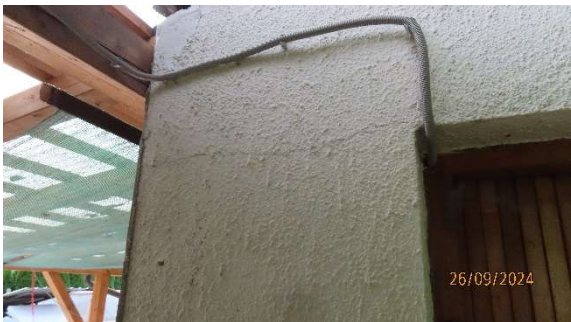
Slika 3: več razpok na območju preklad
