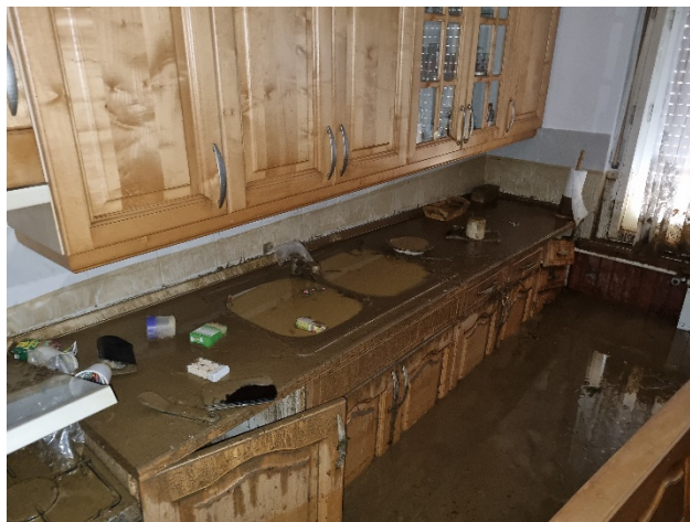
Slika 4: Notranjost objekta po poplavih avgusta 2023 (vir: občina Vuzenica)
