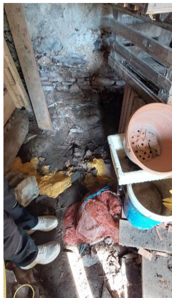
Fotografija 6: Temeljenje objekta v preperlem tufitu (9.5.2024).
