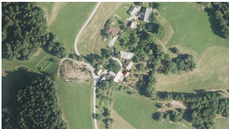
Slika 1: Pogled (DOF) na stanovanjski in gospodarski objekt Raduha 16
