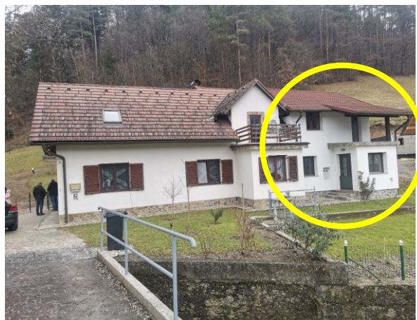
Fotografija 2: Pogled na J fasado objekta (označeno krog - rumeno)
